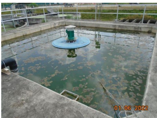
ภาพที่ 2-2 ระบบบำบัดน้ำเสียส่วนกลางทางชีวภาพของโครงการ
