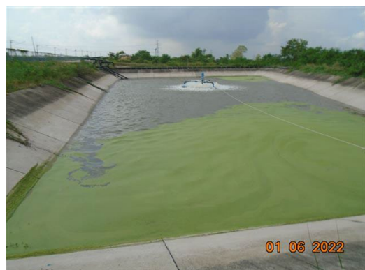
ภาพที่ 2-2 ระบบบำบัดน้ำเสียส่วนกลางทางชีวภาพของโครงการ
