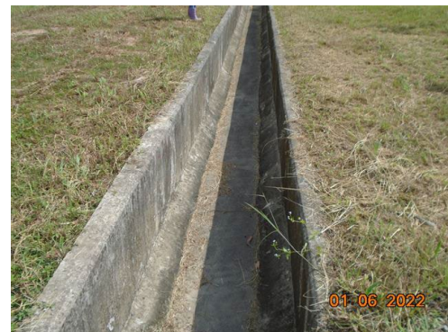
ภาพที่ 2-14 รางระบายน้ำฝนภายในพื้นที่โครงการ
